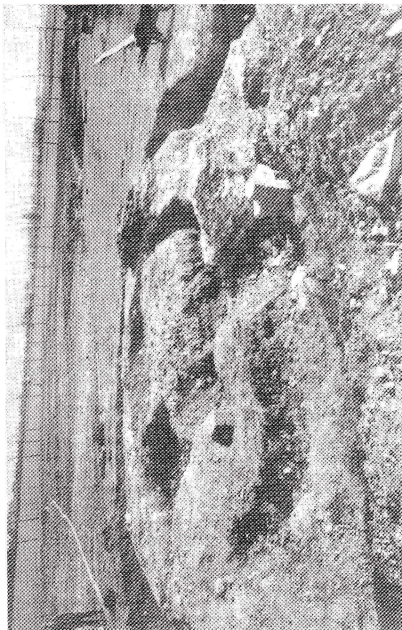
De fundering van de aan de donjon vastgebouwde ronde toren. Foto:Rijksdienst voor Monumentenzorg-Zeist.
