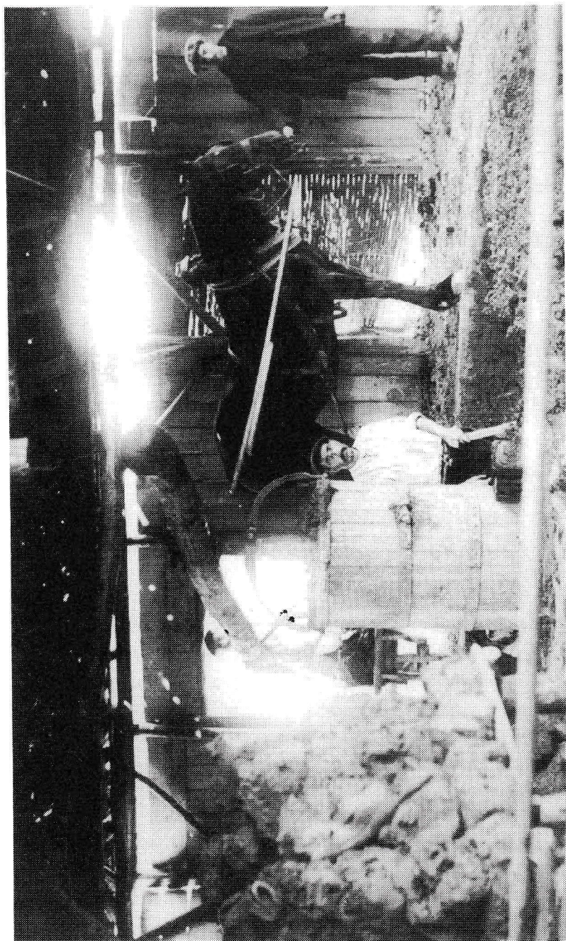
Foto van de mengput. Deze foto is van een fabriek in Halsteren, maar op Zoomvliet gebeurde het mengen op een identieke manier. In de put staat een arbeider die de klei in de houten mengkuip gooid. Het paard liep rond de put en uit de kuip werden blokken gemengde klei geperst. Die werden op het plateau links op de voorgrond gelegd. De man die het paard vasthoudt is Jac. de Leeuw (Collectie: Guillaume de Leeuw-Ossendrecht).
