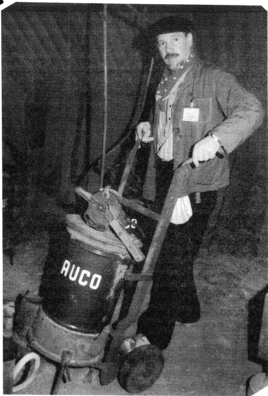
De stookpotjes werden met een steekwagentje naar het juiste stookgat gereden. Karel Schrooyen liet tijdens de open dag in 1993 zien hoe dat precies in zijn werk ging. (Foto: René Hermans-Wouw).
