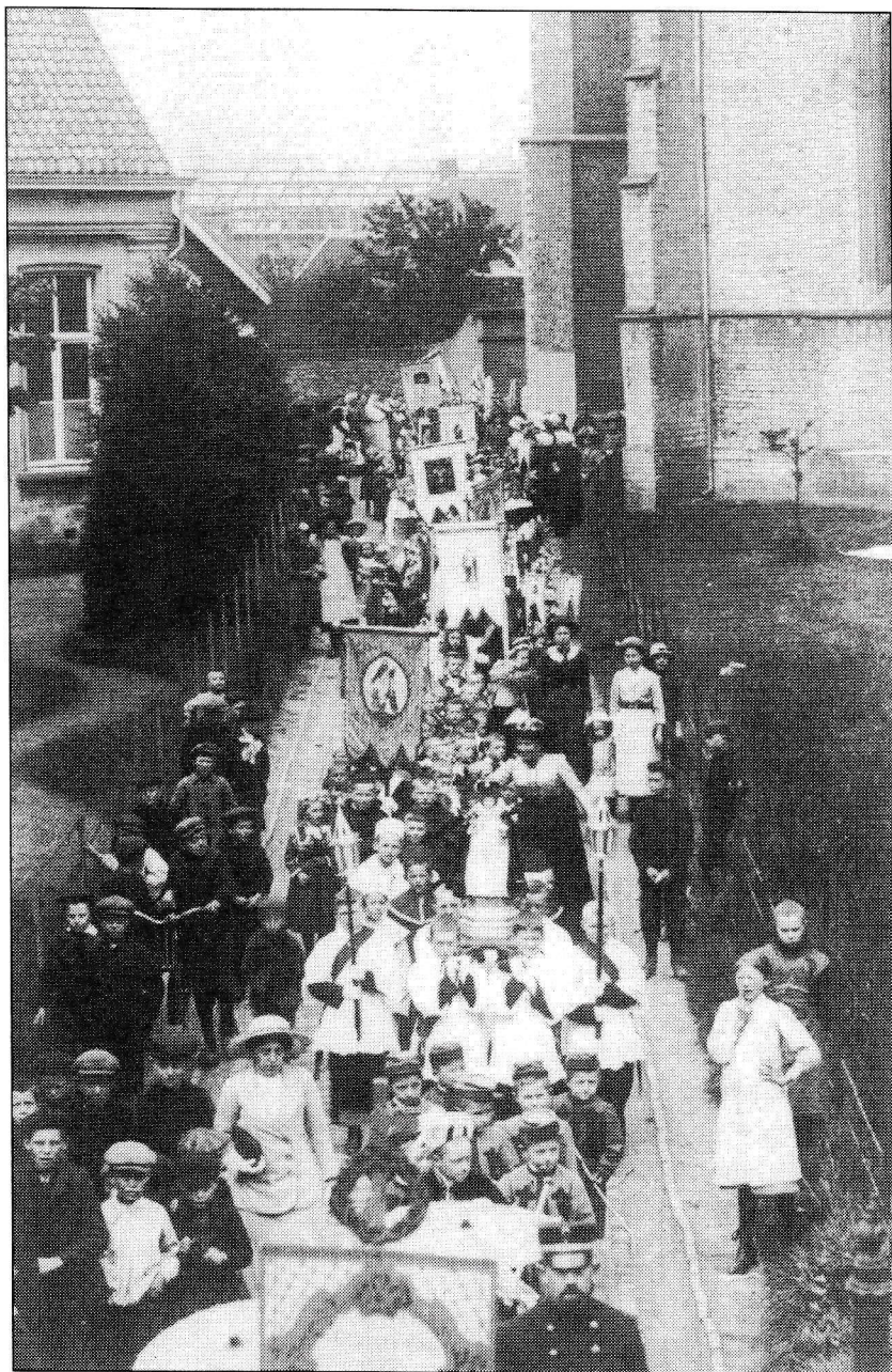
Een foto van een processie in 1914. Tussen de kerk en de woning is een deel van de school in aanbouw te zien. (Foto collectie René Hermans-Wouw)
