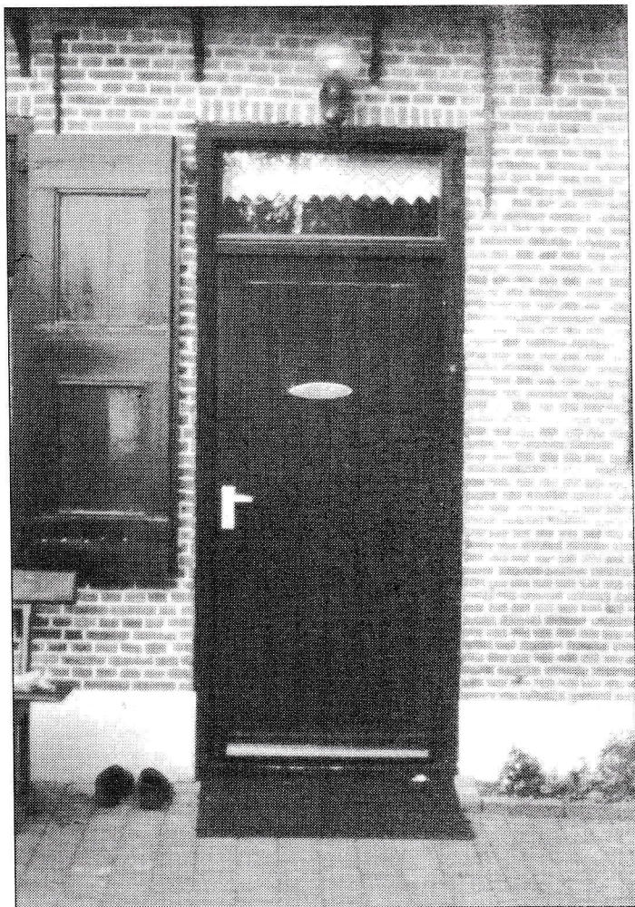
Afb.7 Voordeur in de linker zijgevel. De deur is verhoogd, zoals valt te zien aan het metselwerk in de negge. Onder het bovenraam aan de rechterzijde is sprake van een hoekverband, daarboven van verhakte steen. Aan de linkerzijde is een verhakt hoekverband te zien, zodat de linker negge van de oorspronkelijke deur valt te reconstrueren.
